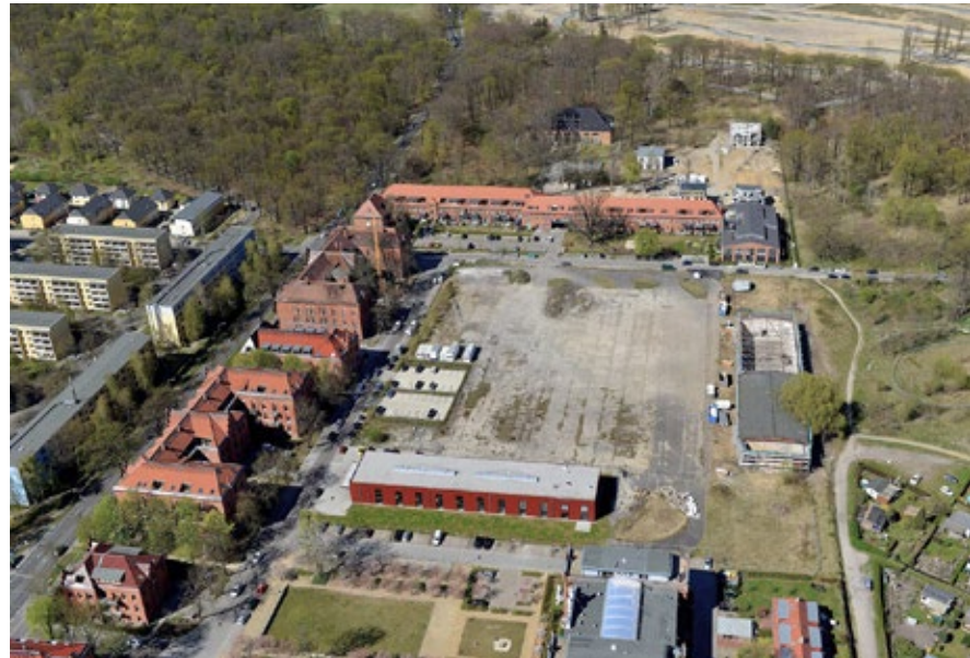
HIER WIRD DIE SCHULE ENTSTEHEN
