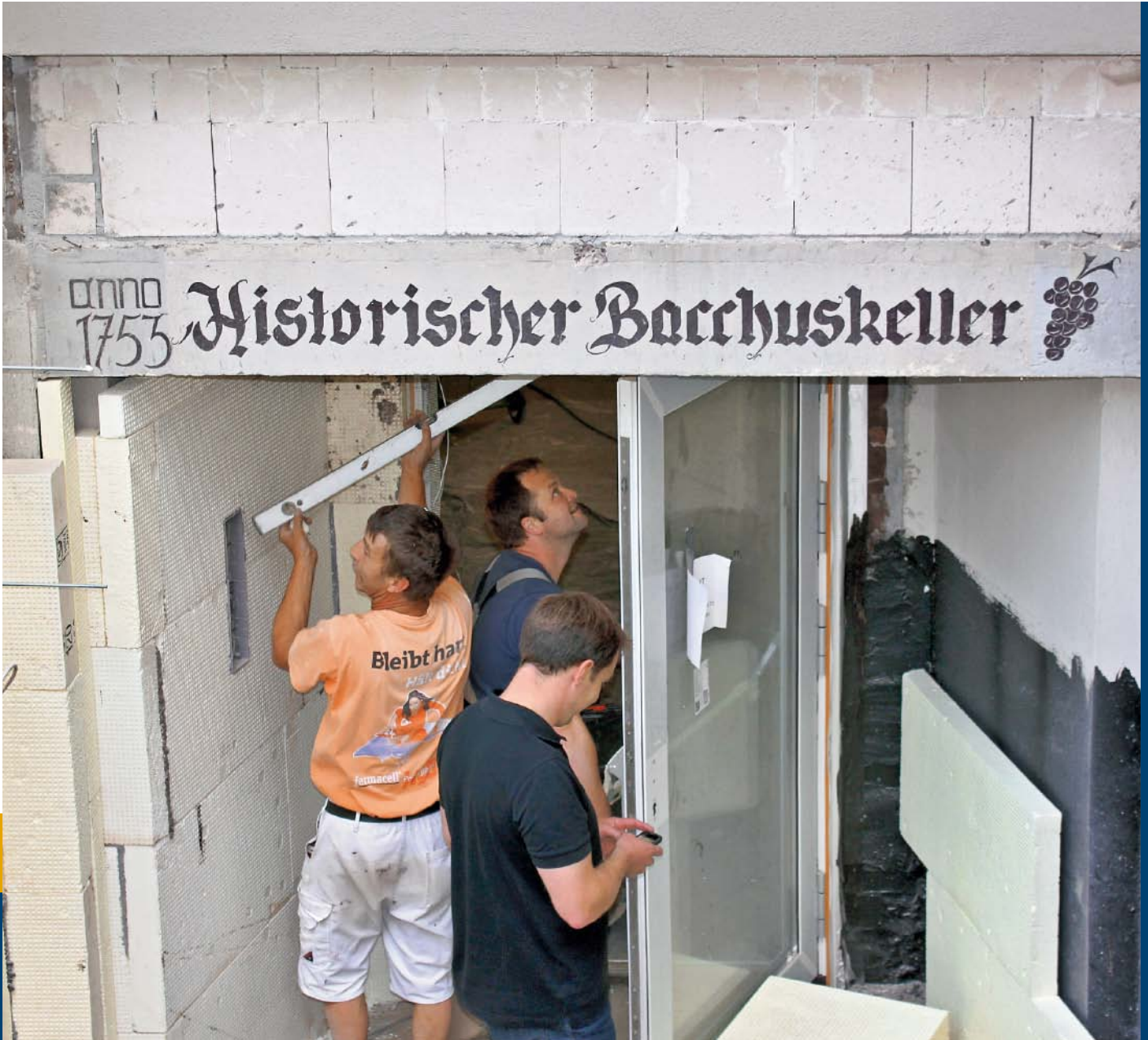
BAUARBEITEN AM ALTEN RATHAUS
