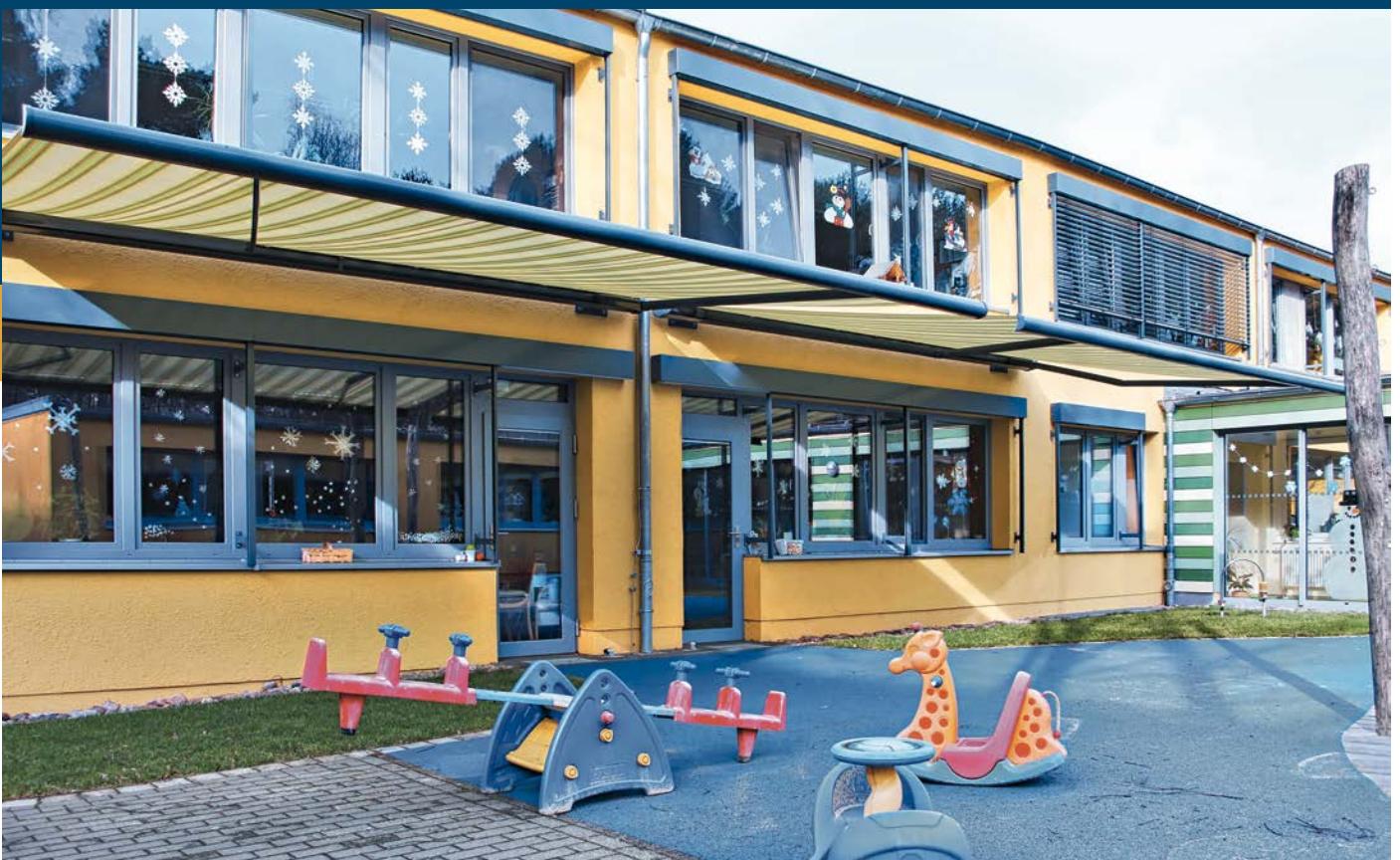
BLICK VOM INNENHOF AUF DEN ZWEIFGESCHOSSER
