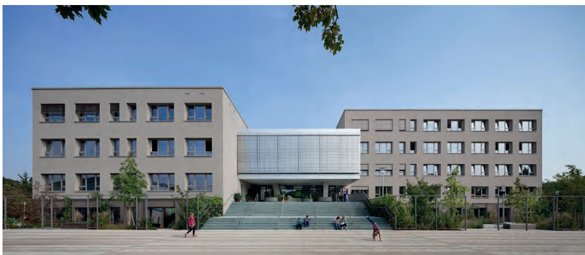
GRUNDSCHULE AM PRIESTERWEG, FRONTANSICHT
